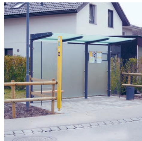
Die Bushaltestelle Ketschelenstraße wurde mit einem neuen Wartehäuschen ausgestattet.
