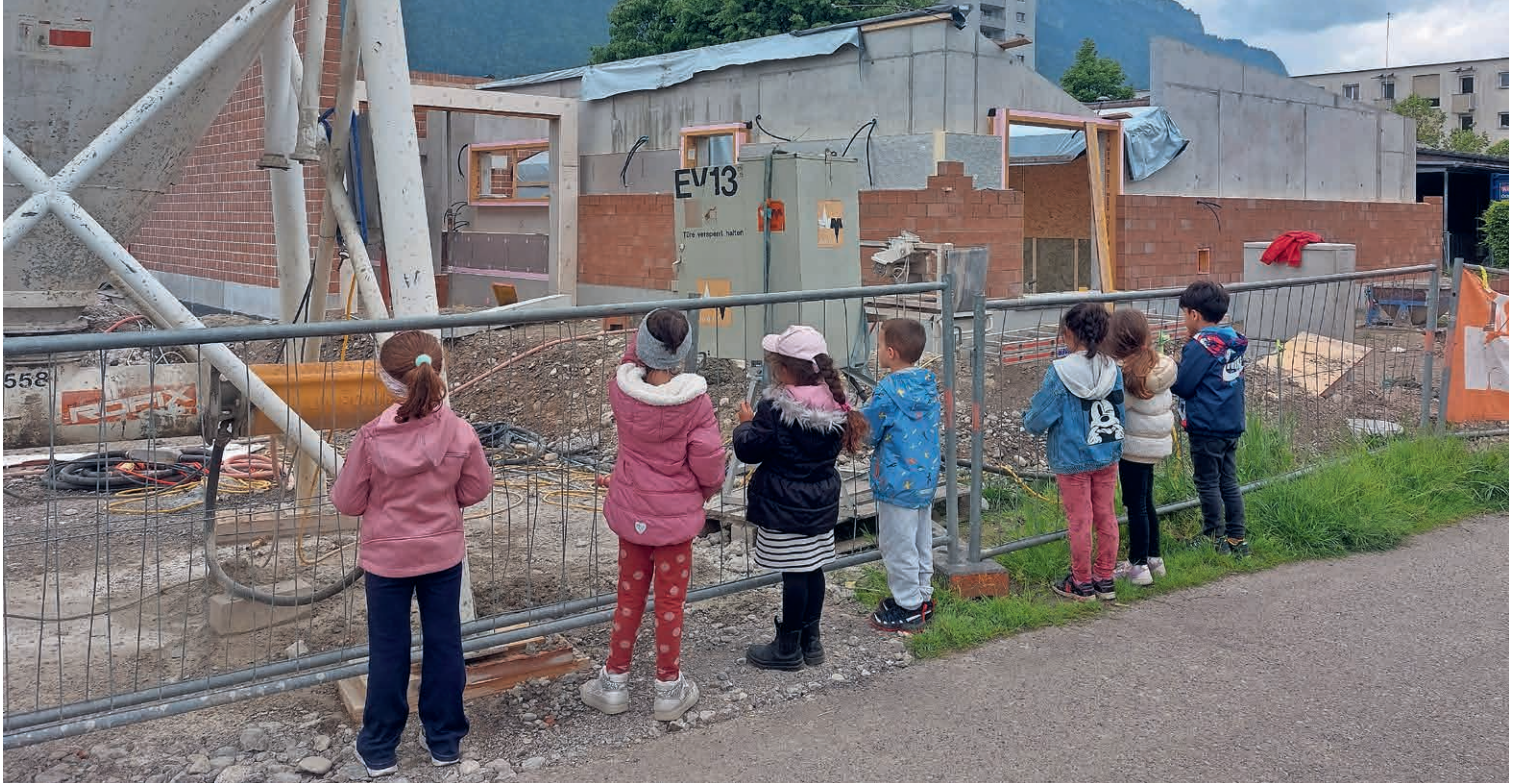
Die Kinder freuen sich bereits: Bis Februar 2025 werden die Bauarbeiten in Tosters abgeschlossen.
