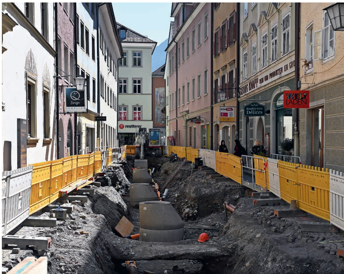
Mittlerweile fehlen nur noch die Pflastersteine. Dann sind auch die Arbeiten in der Schlossergasse abgeschlossen.
