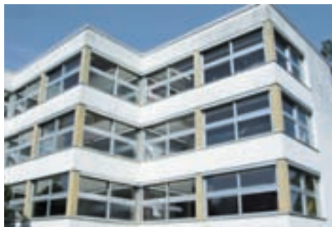
Das Schulzentrum Oberau wird unter Berücksichtigung von Passivhaus-Kriterien saniert.
