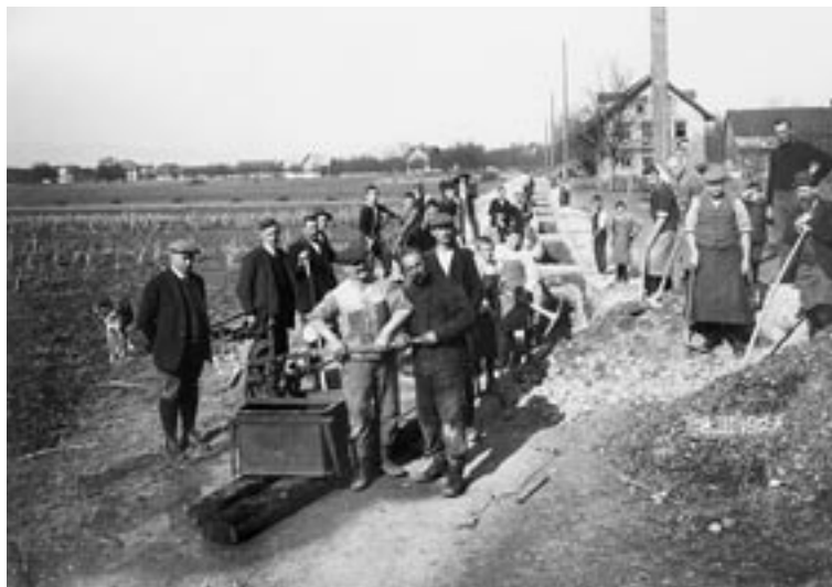
Bau der in den Vereinigungsverträgen versprochenen Wasserleitung nach Gisingen 1927.
