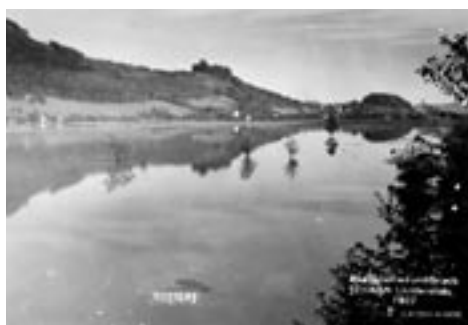
Beim Bruch des Rheindammes 1927 wurde das ganze Liechtensteiner Unterland überschwemmt. Die Wassermassen des Rheins flossen bis nach Tosters.
