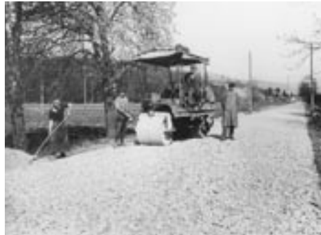
Bau der Illstraße zwischen Tosters und Nofels (1926). (Foto Bojarski)
