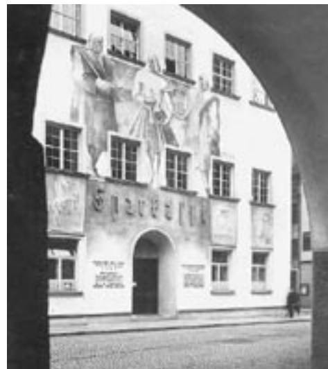
Wo heute die neue Bürgerservicestelle ist, war bis 1967 die Sparkasse und zuvor die Kornhalle untergebracht.
