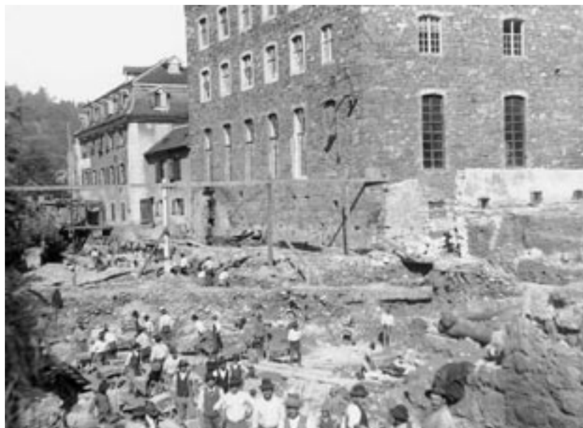
Der Aushub zum Bau des E-Werks um 1905
