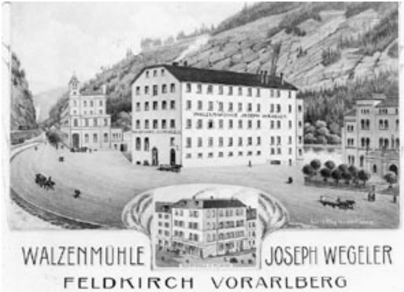
Die Wegeleermühle lieferte als Privatkraftwerk bereits vor 100 Jahren Strom
