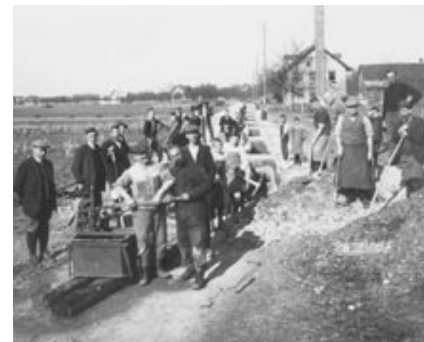
Die Wasserleitung von Feldkirch nach Gisingen wurde 1927 errichtet.
