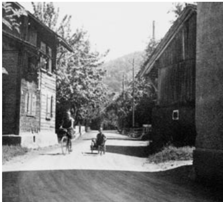
Die Hauptstraße in Gisingen nach dem Ausbau 1937.
