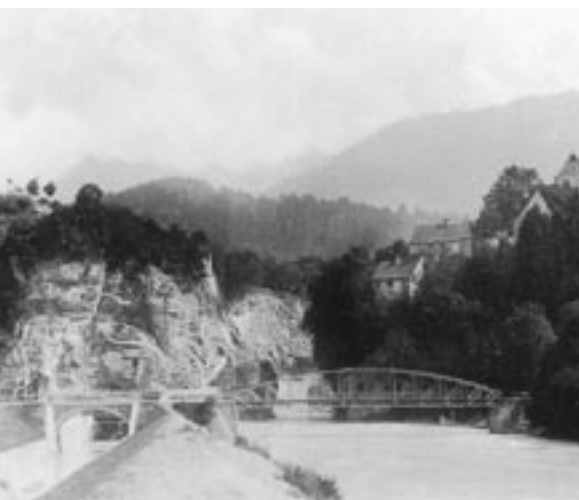
Die erste Brücke über die Ill zwischen Tosters und Gisingen wurde 1884/85 errichtet.
