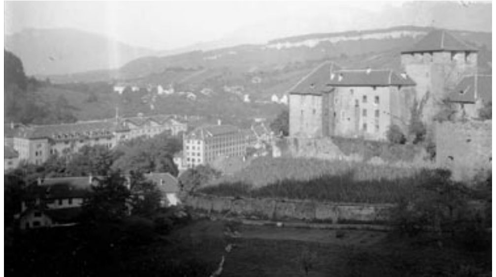
Um 1890. Der Burghang ist mit Weinreben besetzt. Links die Spinnerei Getzner und die Stella Matutina. Gut sichtbar übrigens die an der Außenwand der Burg angebauten Plumpsklos.
