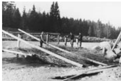
Ein Rost aus Holz und Gestrüpp diente als Unterlage für die Schüttung der Böschungen (Foto: Stadtbaumeister Karl Puchner)
