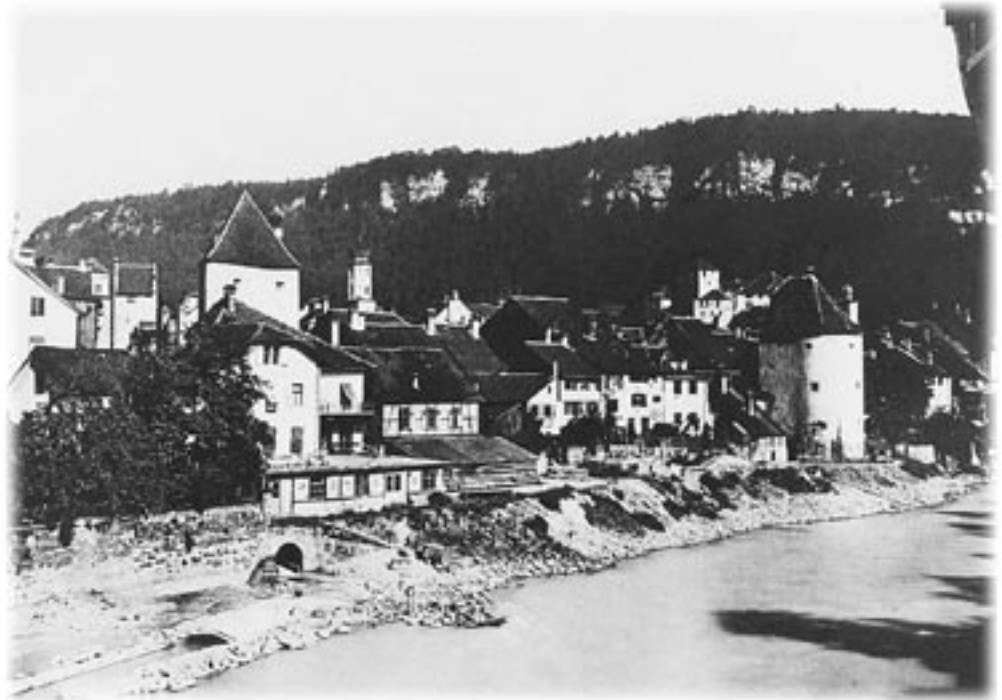
Ende des 19. Jahrhunderts war das Illufer - hier auf Höhe der heutigen Montfortbrücke - noch völlig ungeschützt.
