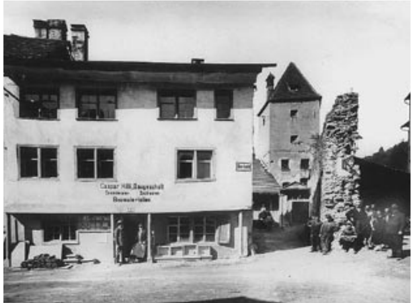
Die Baufirma Hilti an ihrem heutigen Standort
