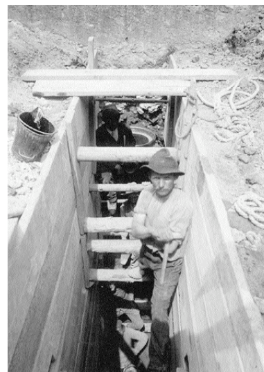
Viele Arbeiter kamen aus dem Trentino. Die Baugruben waren oft viele Meter tief (1908 - 1912).
