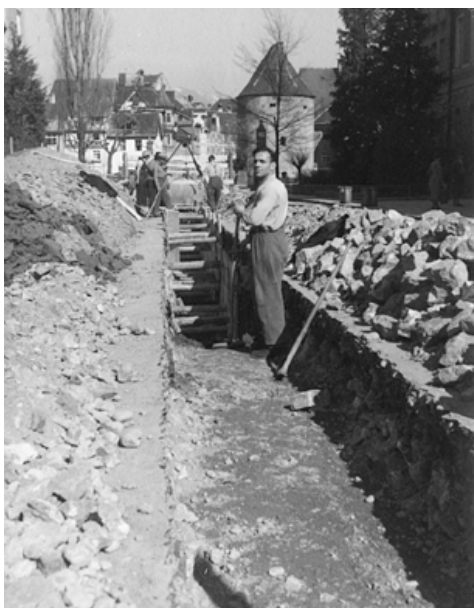
Die Kanalisierung in der Schillerstraße 1938.
