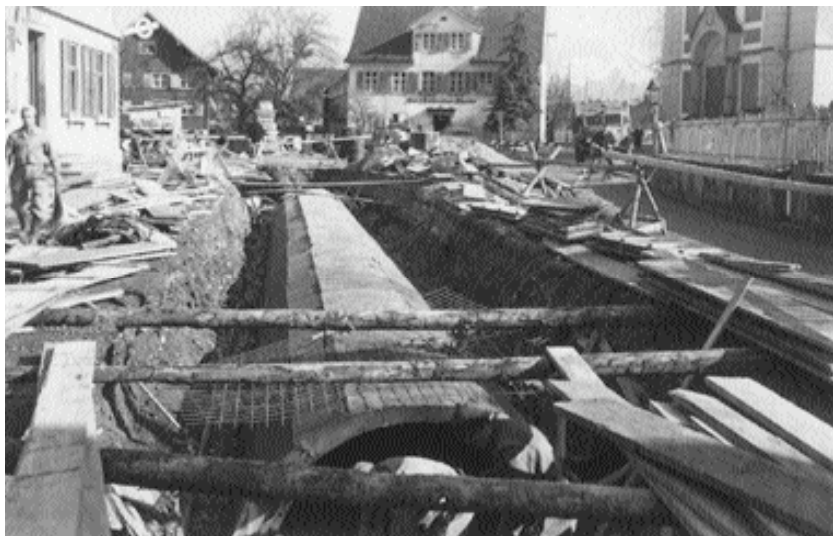
In der Bildmitte das alte Pfarrhaus, damals Kassalokal der Raiffeisenbank in Altstadt (heute Parkplatz) im März 1956.
