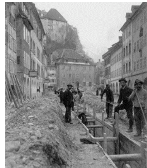
Kanalbaustelle in der Neustadt.
