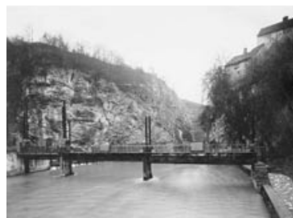
... und das ehemalige Hämmerlewehr.
