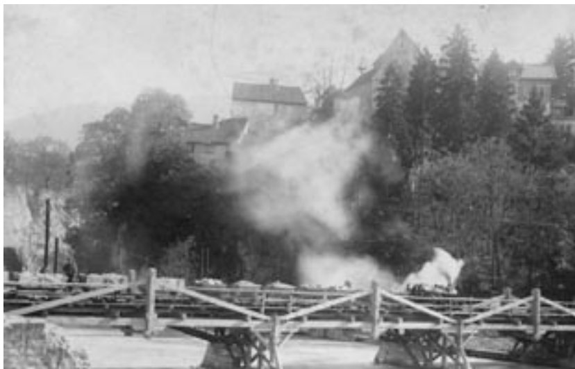
Die provisorische Brücke nach Tosters exakt an der Stelle wo heute die neue Vereinigungsbrücke die Ill quert.
